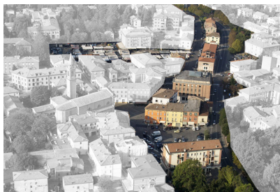
Cavezzo (MO) zone interessate da crolli
